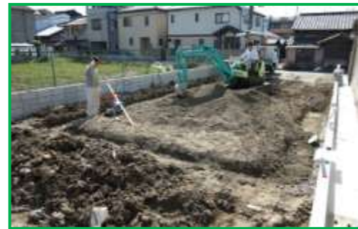
基礎工事スタート
