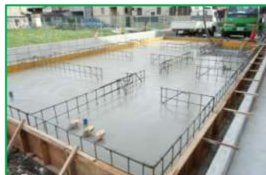
基礎ベースコンクリートの打設
