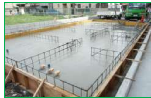
基礎ベースコンクリートの打設
