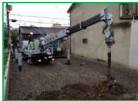
地盤改良工事
